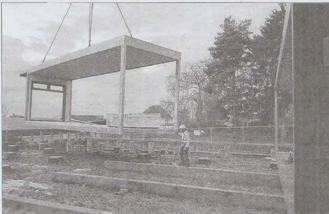
Treize modules de ce type ont été installés et assemblés qui constituent au total une surface de 400 m 2 au groupe scolaire du stade. Photo RL/Philippe CREUX
